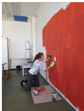
фиг.8 Сигниране на западната стена с керемидено червен цвят
